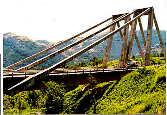
Sopra, il ponte Morandi sulla Basentana
